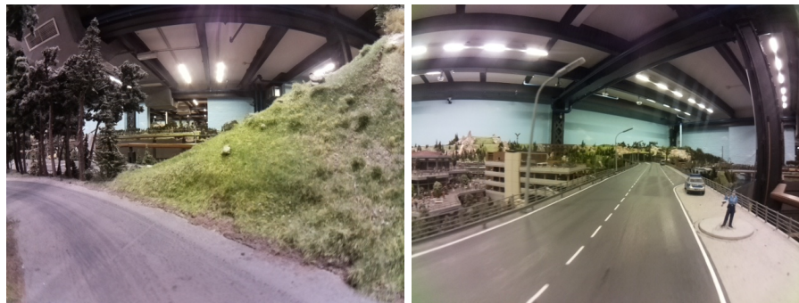
(a) Fahrbahnaußenkante durch Asphaltende (b) Fahrbahnaußenkante mit Fahrstreifenbegrenzung
