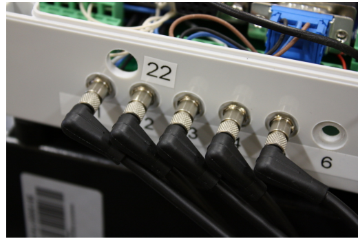
Abbildung 4.5: Montage der Anschlüsse noch unvollständig
